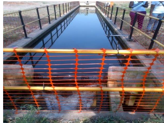
d. Final effluent contact tank
